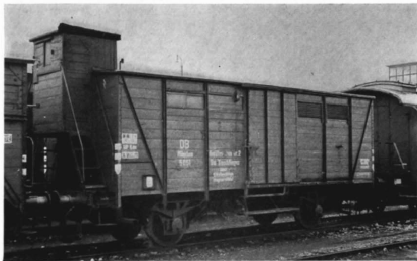
Abb. 1. Das Vorbild unserer heutigen Bauzeichnung: ein zweiachsiger gedeckter Güterwagen der ehemaligen Königlich Sächsischen Staats-Eisenbahnen, der heute seine runden sechs Jahrzehnte auf dem Buckel hat. Vom Äußeren her gleicht er (bis auf das Flachdach des Bremserhauses) in etwa dem bekannten G 10 (Kassel).
