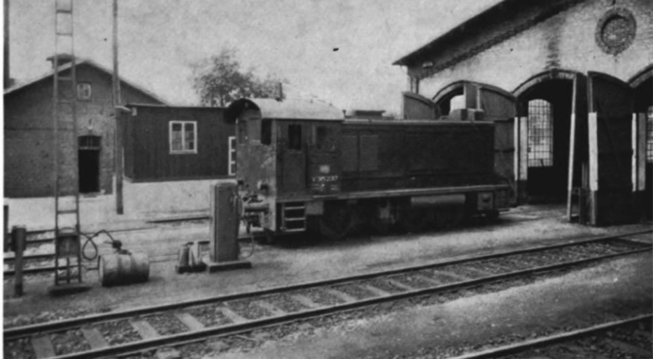
Abb. 3. Das „simple“ Gegenstück zur Großtankstelle der Abb. 1, wie es aber in gar vielen Fällen auf Modellbahnanlagen genügen dürfte: eine kleine Zapfstelle mit grauer Zapfsäule, wie hier im Bw Quakenbrück (an der Strecke Oldenburg–Osnabrück). Das daneben lagernde Ölfaß mit Handpumpe nebst zwei Einfüllkannen dürfte „für alle Fälle“ gedacht sein (oder als Heizölquelle?) und ist ebenfalls leicht nachzubilden.
