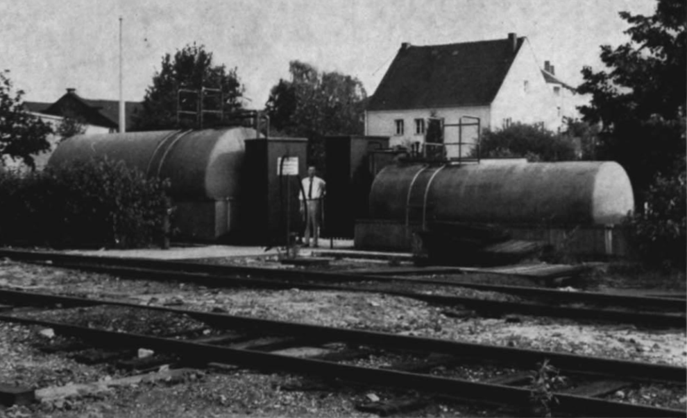
Abb. 5. Eine etwas aufwendigere Dieseltankstelle im Bahnhofsgelände von Fürth/Bay. mit zwei in Olauffangwannen gelagerten Kesseln. Armaturen und Schläuche befinden sich in den beiden rechteckigen Zapfsäulen. Die gesamte Anlage ist auf einem Betonfundament gelagert, das im mittleren Teil bis zum Gleis vorgezogen ist. Als Größen-„Maßstab“ Herr Balcke vom MIBA-Verlag (1,70 m groß).
