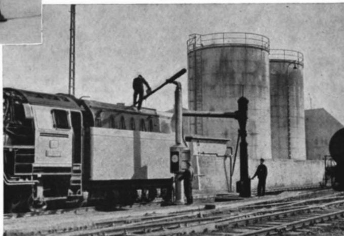
Abb. 6 u. 7. Ein drehbarer, wasserkränähnlicher Dieseltankanschluß, wie er in Amerika häufig anzutreffen und als H0-Bausatz-Modell über die Fa. Old Pullman zu beziehen ist. Bei uns werden ähnliche drehbare Zapfsäulen vornehmlich zum Betanken der öl-befeuerten BR 01 und 44 benutzt. Im Bild rechts ist eine solche Säule (im Bild-Verkleinerungsmaßstab der Baugröße N entsprechend!) im Bw Bebra zu sehen. Im Hintergrund zwei große Öltanks mit je 350 t Fassungsvermögen.
