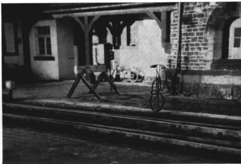
Abb. 13 und 14. Eine inzwischen stillgelegte „Mini“-Dieselkraftstoffzapfstelle für eine Kö entdeckte Herr Arnd Weber aus Bad Homburg v. d. H. im dortigen Bahnhof. Versorgt wurde sie von zwei 2500 l-Tanks im nahegelegenen Wasserturm. Gefüllt wurden die Tanks durch Kesselwagen, deren Elektropumpe an das Lichtnetz angeschlossen wurde. Die Wagen versorgten von Hanau aus auf einer „Rundreise“ mehrere Tankstellen.
