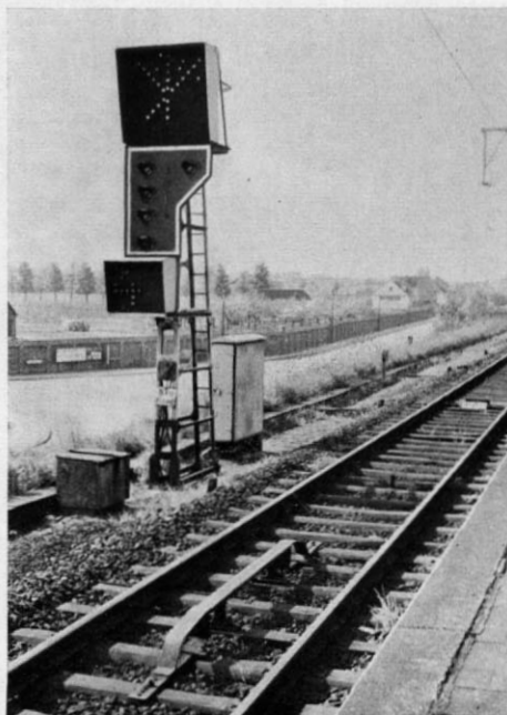
Abb. 1. Keineswegs auf einer Modellbahn-Anlage fotografiert, sondern beim großen Vorbild: Gleiskontakte zur Signal-Überwachung bzw. -Betätigung. Was der Modellbahner seit jeher zu vermeiden sucht, wird ihm bei den Belgischen Eisenbahnen als Musterexemplar groß und überdeutlich vorexerziert: auffällige Gleiskontakte — zwischen den Schienen montiert!
