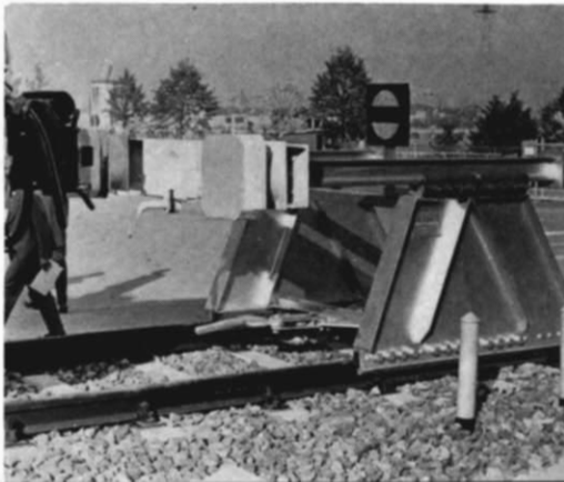
Abb. 2 u. 3. Ein mit einer Betonmauer eingefasster Prellbock, bei dem die Stoßkräfte durch die Erdanschlüpfung hinter den Holzbohlen aufgefangen werden (Foto: S. Tappert, Ansbach). Das moderne Gegenstück (Bild unten): ein neuzeitlicher Gleisbremsprellbock der Fa. Rawie (Foto: MIBA).
