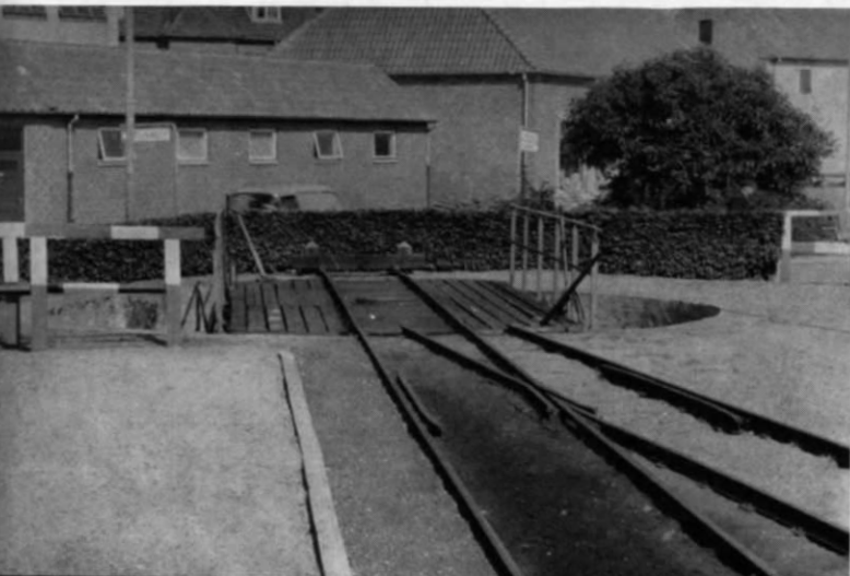
Abb. 4 u. 5. Auch im Bf. Nexø der dänischen Insel-Kleinbahn auf Bornholm griff man zu einer Drehscheibe als Weichenersatz, da der zur Verfügung stehende Platz durch ein im Wege stehendes Gebäude für eine Weiche (mit entsprechend langem Ausziehgleis) einfach nicht ausreichte. Herr Klaus Briese aus Berlin sandte uns Foto nebst Lageplan des Bahnhofs Nexø. Man sieht: auch anderwärts greift man beim Vorbild zur Drehscheibe als Weichenersatz.
