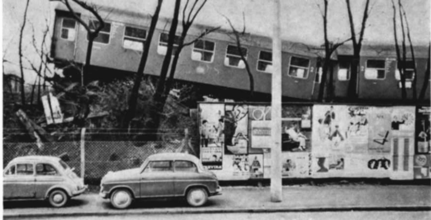
Abb. 1. Einen etwas zu heftigen Stoß gab kürzlich eine Rangierlok im Nürnberger Hauptbahnhof diesen dreiachsigen Umbauwagen, die – trotz Hemmschuh – mit erheblicher Wucht einen Prellbock älterer Ausführung überrannten. Dank des Prellbocks (der hinterher allerdings nicht mehr als solcher erkennbar war) kamen die Wagen zwar zum Stehen, aber ein Sachschaden von rund 5000 DM war nicht mehr zu verhindern. (Foto: F. Ulrich, Nürnberg)
