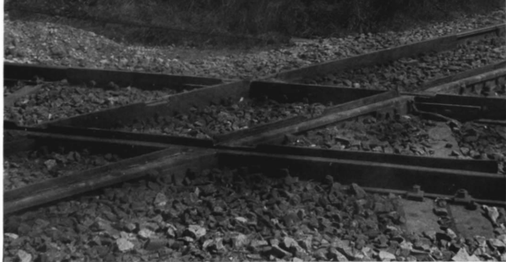
Abb. 1. Deutlich zu sehen: die nicht unterbrochenen Gleise der Bahnlinie Reutlingen – Schelklingen, über die die meterspurige Straßenbahn buchstäblich „hinweghoppeln“ muß.
