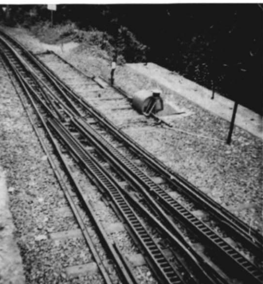
Abb. 2. Zahnradbahn-Weiche der Drachenfels-Bahn mit jeweils 2 beweglichen Schienen- bzw. Zahnstangen-Teilen (s. a. Abb. 3).
