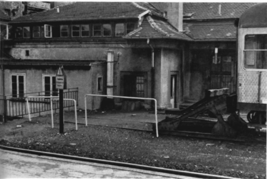
Abb. 9. In Bielefeld sind diese beiden alten Prellböcke zu finden, der vordere davon in bremsender Ausführung (mit entsprechendem Durchrutsch-Weg). Man beachte auch das Schutzgelenk, das zum umsichtigen Überqueren der Gleise anhält. (Foto: MIBA)
