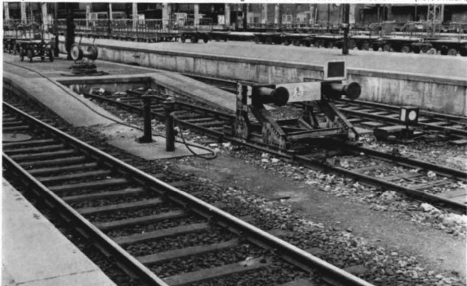
Abb. 10. Ein mit Puffern ausgerüsteter Prellbock – ebenfalls in bremsender Ausführung – im Stuttgarter Hauptbahnhof. Auch hier ist ein ausreichender Bremsweg hinter dem Prellbock vorhanden. (Foto: MIBA)
