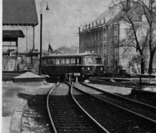
Abb. 2 u. 3. Im Bf. Remscheid-Lennep übernimmt ebenfalls eine Drehscheibe das Umsetzen der Loks, nachdem für eine Weichenstraße (wegen des Bahnhofs-Vorplatzes) nicht mehr genügend Raum vorhanden ist. Auf dem Bild rechts dreht sich gerade ein Schienenbus „in die richtige Lage“ (s. a. Heft 15/XII, S. 589). Anstelle der kompletten Drehscheibe könnte in solchen Fällen auch eine Segment-Drehscheibe vorgesehen werden in der Art, wie wir sie z. B. in Heft 11/XVII, S. 516, bildlich vorstellen.
