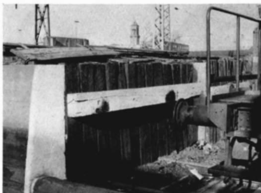
Abb. 2 u. 3. Ein mit einer Betonmauer eingefasster Prellbock, bei dem die Stoßkräfte durch die Erdanschlüpfung hinter den Holzbohlen aufgefangen werden (Foto: S. Tappert, Ansbach). Das moderne Gegenstück (Bild unten): ein neuzeitlicher Gleisbremsprellbock der Fa. Rawie (Foto: MIBA).
