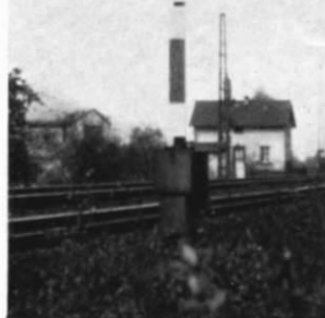
Abb. 2. Älteres Haupt- und Vorsignal mit Geschwindigkeitsanzeiger Zs 3, hier in der Bauart mit außenliegendem Ersatzsignal Zs 1.
