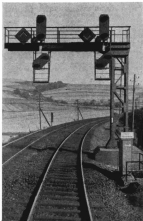
Abb. 7 u. 8. Die im Text näher erläuterte „fliegende Überholung“ zwischen Bebra und Cornberg mit Gleiswechselanzeiger (Zs 6) und Fahrregelungsanzeiger (Zs 4 bzw. Zs 5) im Verein mit Lichthaupt- und -vorsignalen zur Streckensicherung.
