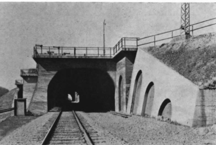
Abb. 52. Ein Beton-Tunnelportal, das bereits vorglich für eine später zweigleisige Strecke ausgelegt wurde. Die am gesamten Bauwerk anzutreffenden Bogen sind auch an der schrägen Stützmauer vorn rechts zu finden – eine Anregung für ähnlich ausgeführte Mauern im Modell. Man beachte im übrigen die diversen Geländer und Schutzgitter an den einzelnen Bauwerken, die auch auf Modellbahnanlagen überall dort angebracht werden sollten, wo in natura für Menschen Absturzgefahr bestehen könnte.
