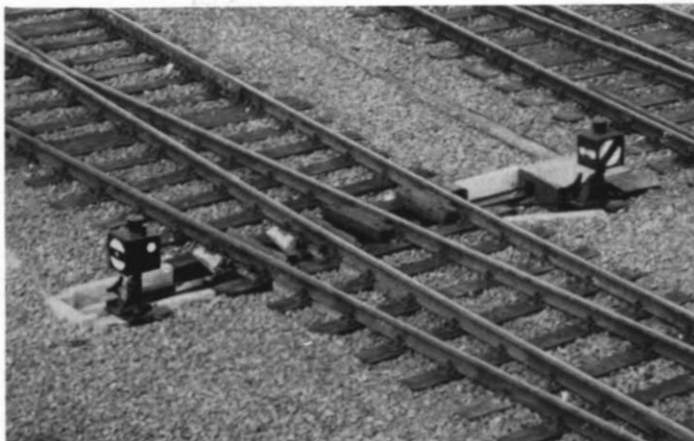
Abb. 1 zeigt eine doppelte Gleissperre im Bereich der Flügelgleisen einer Weiche. Gleichzeitige Betätigung durch gemeinsames Gestänge über einen Seilzug. Bei einer Entgleisung werden allerdings gleich 2 Abstellgleise blockiert — ein vertretbarer Standpunkt, da 2 blockierte Abstellgleise immerhin „besser“ sind als ein gefährdetes Hauptgleis.
