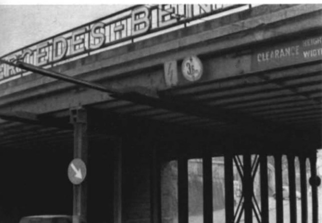
Abb. 3. Straßenbahn-Fahrleitungsaufhängung unter einer Unterführung im Stadtgebiet von Nürnberg. Das Schutzdach ist vor der Brücke nicht nach oben abgewinkelt, sondern gerade weitergeführt (mit stark vorgezogener Befestigungsschiene für den Fahrdraht). Beachten Sie auch die beiden an der Brücke angebrachten Warnschilder. (Foto: MIBA-Archiv)
