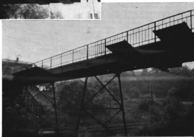
Abb. 5. Vorn im Bild: Schutzverschaltung über einer Eisenbahn-Fahrleitung. Außer dieser Ausführung, die Herr Dirmeier als Grundlage für seine Skizze Abb. 2 diente, gibt es noch eine Reihe anderer Bauformen, die wir Ihnen aber leider mangels Bildmaterial heute noch nicht vorstellen können. (Foto: W. Dirmeier, Frankfurt)
