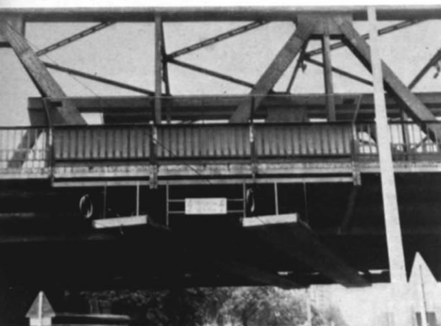
Abb. 4. Eine weitere Variante der Straßenbahn-Fahrleitungsaufhängung mit zusätzlich am Brückengeländer angebrachten Schutzwänden und waagrecht herausragendem Schutzgitter, die ein Berühren der spannungsführenden Teile (auch mit Drahtstücken, Stecken, Stangen u. dergl.) verhindern bzw. unmöglich machen sollen. (Foto: W. Dirmeier, Frankfurt)
