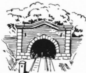
Abb. 10. Ein giebelförmiges Portal mit interessantem Farbkontrast zwischen Sandsteinquadrern und Backsteinwand.
