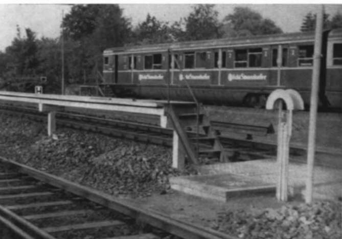
Abb. 2 zeigt ebenfalls einen Dienstbahnsteig, aber in Beton-Bauweise. Bei der Modellherstellung können Sie sich im großen und ganzen an die Zeichnungen in Heft 16/XVII sowie an die heutigen Abbildungen halten, zumal sich die Höhe der Dienstbahnsteige auf Ihrer Modellbahn-Anlage ohnehin nach dem verwendeten Gleis- und Fahrzeugmaterial richtet.
