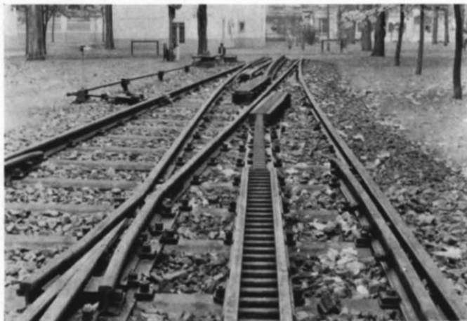
Abb. 4, 5 und 6. Oben links eine Zahnradbahn-Weiche gemäß Abbildung 2 mit über den Schienenprofilen liegenden Zahnstangen. Die Weiche ist auf dem Gelände der TH Karlsruhe zu Versuchszwecken aufgebaut. Das Bild rechts zeigt deutlich die auf Gleitflächen verschiebbar gelagerten Zahnstangen-Segmente. Wie das Einlaufstück zu Beginn bzw. am Ende eines Zahnstangen-Gleises beim Original aussieht, ist auf dem Foto unten links gut zu erkennen. (Fotos: W. Flügel, Karlsruhe).
