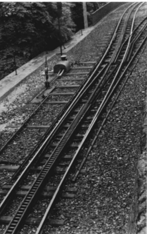
Abb. 1. Eine Zahnrad-Weiche der Drachenfels-Bahn entsprechend Abb. 3. (Foto: E. Enigk, Reichenbach)
