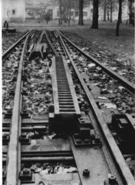
Abb. 4, 5 und 6. Oben links eine Zahnradbahn-Weiche gemäß Abbildung 2 mit über den Schienenprofilen liegenden Zahnstangen. Die Weiche ist auf dem Gelände der TH Karlsruhe zu Versuchszwecken aufgebaut. Das Bild rechts zeigt deutlich die auf Gleitflächen verschiebbar gelagerten Zahnstangen-Segmente. Wie das Einlaufstück zu Beginn bzw. am Ende eines Zahnstangen-Gleises beim Original aussieht, ist auf dem Foto unten links gut zu erkennen. (Fotos: W. Flügel, Karlsruhe).
