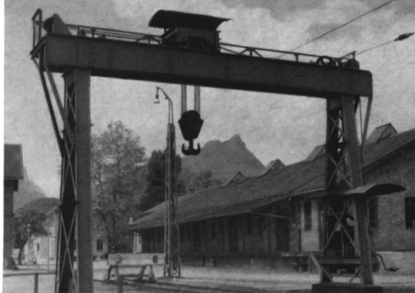
Abb. 6. Der hier abgebildete Bockkran, den Herr Wolfgang Fischer aus Berlin-Lankwitz im Güterbahnhof Bad Reichenhall fotografierte, dient außer zum Heben von Lasten auch noch als „Oberleitungs-Mast“: an seinem Querträger sind Fahrleitungen und Halteseile der Oberleitung befestigt.
