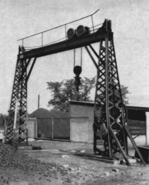
Abb. 10. Herr Rolf Ertmer aus Paderborn sandte uns dieses Foto eines handbetriebenen Krans, dessen Rollbock auf zwei dicht nebeneinander liegenden Schienen läuft und mittels Kettenzug bewegt wird. Abb. 12 zeigt den Kran von der anderen Seite.
