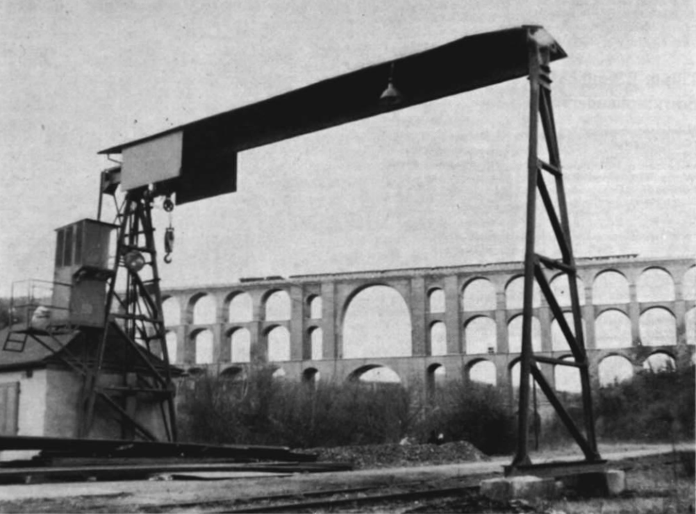
Abb. 1. Das Vorbild für unsere nebenstehende Bauzeichnung. Herr K. aus Mitteldeutschland fotografierte diesen Bockkran in der Umgebung von Mýlau. Bei dem im Hintergrund aufragenden imposanten Viadukt handelt es sich um eine der größten Steinbrücken in Europa; es ist die Göltzschthalbrücke (Strecke Zwickau – Plauen).
