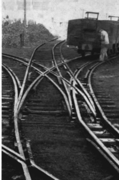
Abb. 6. Eine ganz „vertrackte“ Sache: Diese symmetrische (und doch unsymmetrische) Doppelspur-Dreiwegweiche (in Waver/Belgien)! Wer soll sich durch dieses Schienengewirr noch durchfinden? (Foto: V.B.S.T.)
