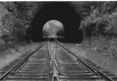
Abb. 2. Diese Aufnahme stammt von einer amerikanischen Bahnlinie, bei der die zweigleisige Strecke an diesem Tunnel zu einer „eingleisigen“ Vier-Schienen-Strecke (Gauntlet Track) zusammengefaßt wurde.
