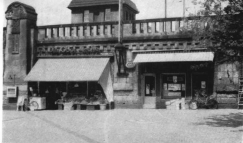
Abb. 31. Ein Beispiel aus Hannover: Läden im künstlichen Damm, jedoch nicht in Gewölbeform. Bemerkenswert: der „allegorische“ Pfeiler sowie die durchbrochene Steinbrüstung. (Foto: B. Rose, Hannover)
