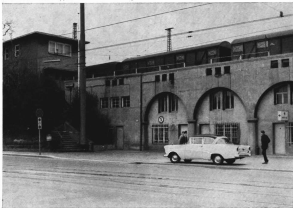
Abb. 36. Der benachbarte Abschnitt des Dammbauwerkes von Abb. 34, diesmal jedoch nicht mit Geschäften in den Gewölbebogen, sondern mit einer Sanitätsdienststelle. Links schließt sich eine Strecke geschütteten Dammes an. Eine Treppe führt zu einem Dienstgebäude auf dem Bahngelände.
