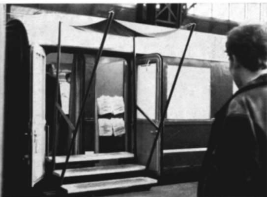
Abb. 2. Ein kleines Stück dünner Stoff (oder Papier), vier gerade Drahtstücke und drei dünne Streifen Sperrholz (für die Stufen) — das ist alles, was man ggf. für die Nachbildung eines solchen Ausstellungs-Zug-Empfangsportals benötigt. (Foto: Heinz Kiehn, Hamburg)
