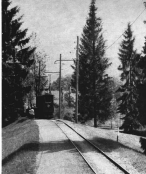
Abb. 6. Neben der Strecke auf dem Damm verläuft auch noch ein Fußweg. Die Oberleitung ist an einfachen Holzmasten montiert.
