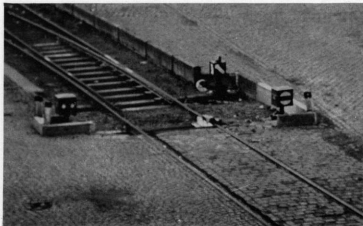
Abb. 4. Hart stoßen sich die Dinge in Iserlohn: Hier befindet sich die Gleissperre direkt hinter einer Weiche und soll das Abrollen von Wagen aus beiden Gleisen über die Ladestraße verhindern. (Foto: Walter Oberschachtsiek, Iserlohn)
