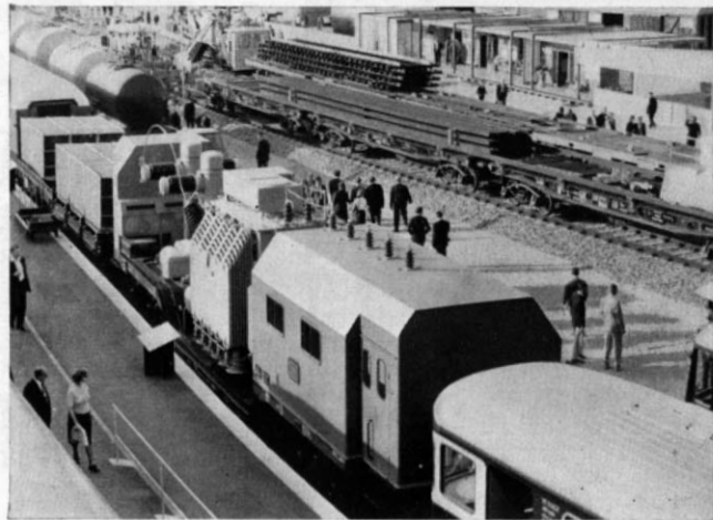
Abb. 6-9. Diese Bilder zeigen Einzelheiten eines fahrbaren Umspannwerkes neuester Bauart, das von den Firmen Siemens und Krupp gebaut und auf der IVA 1965 ausgestellt wurde. Mit ihm werden die auf den Fernleitungen herangeführten 110 000 Volt auf die für die Oberleitungspeisung benötigten 15 000 Volt herabtransformiert. In den geschlossenen Kabinen sind die Kontrolleinrichtungen sowie die Betätigungsvorrichtungen für die Hochspannungsschalter untergebracht. Maximale Fahrgeschwindigkeit dieses Fahrzeuges: 65 km/h.
