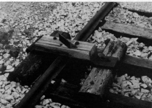
Abb. 5. Zwar primitiv anmutend, aber hier offensichtlich ausreichend: eine Holzbalken-Gleissperre der schmalspurigen Härtsfeldbahn (Aalen – Dillingen). Die Sicherung gegen unbefugtes Öffnen erfolgt durch ein stabiles Vorhängeschloß. Foto: GERA
