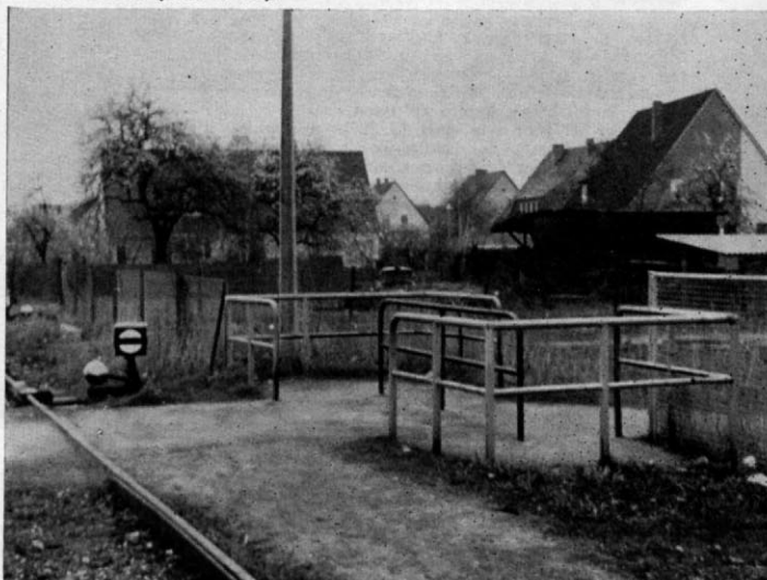
Abb. 7. Ein typisches Leitgeländer, durch das die Überweg-Benutzer zur Streckenbeobachtung gezwungen werden. Die Laterne im Hintergrund ist keine Weichenlaterne, sondern gehört zu einer Gleissperre mit Handhebel (s. a. S. 418).
