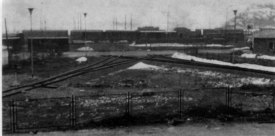
Abb. 3 und 4. Obgleich der Platz für eine – zumindest für das Wenden von Loks – zweifellos günstigere Drehscheibe hier ohne weiteres vorhanden wäre, hat man am Brenner-Paß dieses Gleis-Fünfeck installiert, dessen einer „Ast“ sogar noch die Haupt-Durchgangsgleise quert! Unglaublich aber wahr! Bei der großen Bahn ist eben nichts unmöglich!
