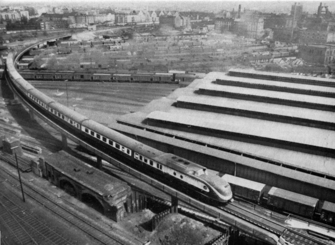
Abb. 1. Ein moderner Zug auf einer modernen Brücke – und doch interessieren in diesem Fall die Fundamentreste der alten Brückenauffahrt mehr: Deutlich ist die Gewölbebauweise zu erkennen, der „Stein des Anstoßes“ zur heute beginnenden Artikelserie. Foto: DB-Direktion Hamburg
