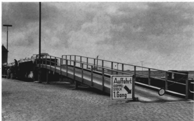
Abb. 9. Diese Rampe in Westerland dient nur zur Beladung der oberen Plattformen vom Kopf der Wagen her; auf die unteren Plattformen fahren die Autos von der Seitenrampe aus (s. a. Abb. 10).
