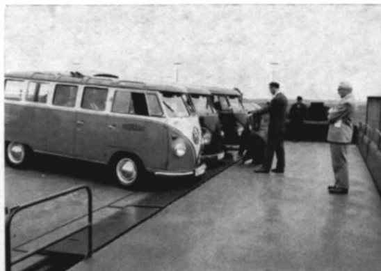
Abb. 10. Weniger Platz in der Tiefe (als in Abb. 5) erfordert diese Kombination von Kopf- und Seitenrampe. Es ist die gleiche Verladeanlage wie in Abb. 9. Die Rampen für die Beladung der oberen Waggon-Plattformen sind übrigens in der Wirklichkeit Stahlkonstruktionen. Skizze ca. M 1:2,5 für H0.
