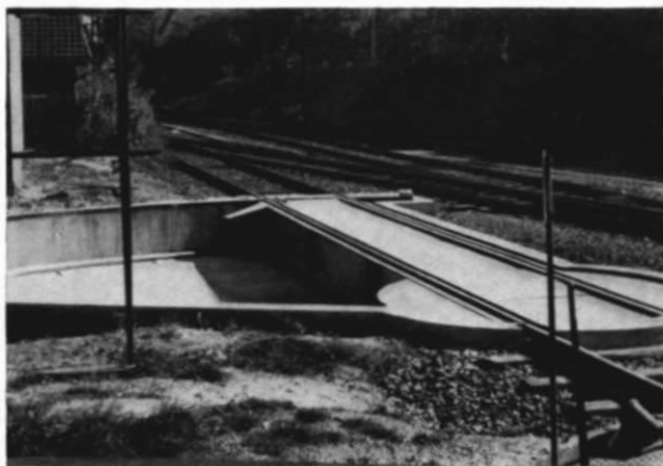
▼ Abb. 2. Die Schwenkbühne der Segment-Drehscheibe ist eine Stahl-Konstruktion, ihr „Bett“ dagegen ein Beton-Bauwerk.
