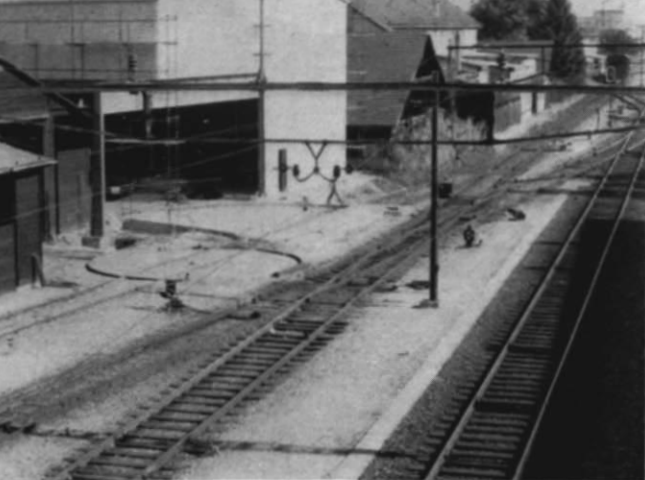
▲ Abb. 1. Der „Engpaß“ im Bahnhof Biel-Mett (Schweiz). Vor den Lagerhallen vorn die kleine Wagen-Drehscheibe und dahinter die Schwenkbühne (Segment-Drehscheibe), die übrigens noch in die Halle hineinreicht.
