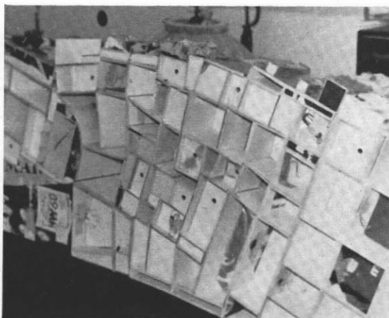
Abb. 1. Verschachtelt wie die Bienenwaben, so bietet sich „Seppmaringen“ von unten dar. Durch die in einzelnen Platten vorhandenen Löcher werden die Beleuchtungsstrippen geführt.
