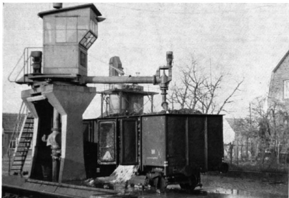
Abb. 1. Das Original der Zuckerrüben-Ausspüleinrichtung auf dem Werkshof der Zuckerfabrik in Gronau. Entdeckt und fotografiert wurde es von Herrn Hartmut Kruse, Gronau. Die Rüben „verschwinden“ in einen unterirdischen Vorratsbunker, dessen „Ladeluke“ sich zwischen dem Gleis und dem Beton-Sockel befindet.
