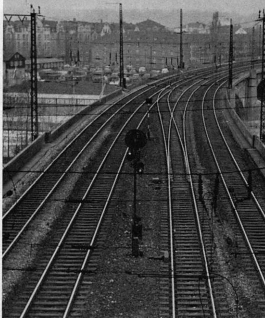
Abb. 14. Welche Bahnhofseinfahrten (oder -Ausfahrten) im Bogen wären möglich, wenn es zu den jetztigen Gleisen noch zwei weitere Parallelgleisbögen gäbe! (Die hier ersichtlichen schlanken Bogenweichen wollen wir bescheidenerweise vorerst von unserer Wunschliste streichen). Daß solche Parallelbogengleise und die erwähnten spitzeren Weichen eine bedeutende Umsatzsteigerung für jede Herstellerfirma bedeuten würden, steht für uns außer Zweifel. – Das Bild von der Rosensteinbrücke Stuttgart-Bad Cannstatt stammt von Herrn F. Willke, Stuttgart.
