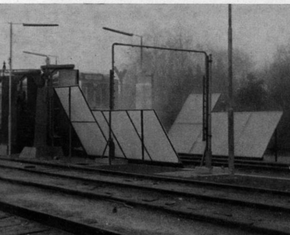
Abb. 10 u. 11. Zum Schluß der Reinigung müssen die Fahrzeuge förmlich durch eine Wasserwand hindurchfahren, die aus einem „Rohr-Portal“ (Abb. 12) hervorsprüht. Die transparenten Schutzschirme sind gut zu sehen, desgleichen auch noch senkrechte Sprührohre, die die Seitenwände nach dem Verlassen des Rohrportals zusätzlich nochmals absprühen. Die Schutzschirme sind auch hier transparent und bestehen wohl aus einem glasfaser-verstärktem Kunststoff (wie z. B. bei modernen Balkonverkleidungen).
