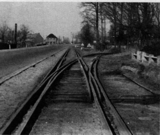
Abb. 6. Eine etwas komplizierte Weiche der doppel-spurigen (Normal- und Meterspur) Strecke zwischen Bf. Mol und den Fabrikanlagen am Kempischer Kanal (Belgien). Eine weitere Kuriosität: Die Normalspur-waggons werden von einer Schmalspurlok gezogen, die mit normalen Eisenbahnpuffern versehen ist! (Foto: H. Notenbaert, Turnhout/Belgien)
