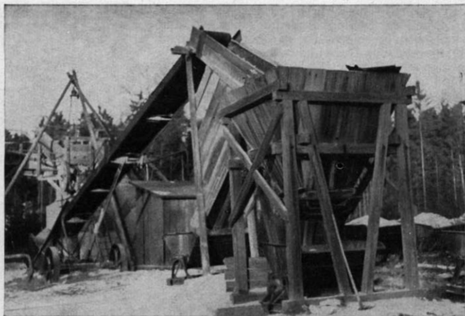
Abb. 3. Balken und Bretter bedeuten zwar nicht die Welt, wenigstens nicht in diesem speziellen Fall, aber sie sind der Grundbaustoff für die Schüttgut-Verladeeinrichtung, die Herr Barthel im Taunus entdeckte. (Foto: H. Barthel, Hofheim/Ts.)
