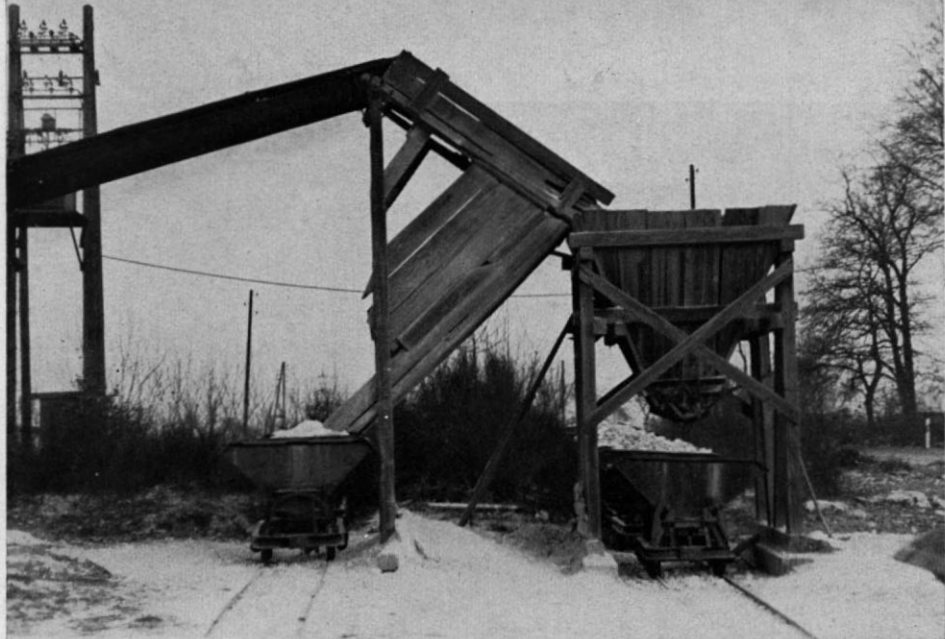
Abb. 1. Die Verladeeinrichtung „en profil“: Aus dem Trichter-„Bunker“ rechts wird offensichtlich das Grob- gut verladen, während das Feingut durch ein Sieb in der oberen Rutsche fällt und über die untere Rutsche in die auf dem linken Gleis bereitstehenden Wagen rinnt.
