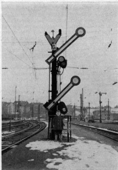
Abb. 2. Dieses wegen der darüberliegenden Oberleitung ebenfalls stark gekürzte zweiflügelige Ausfahrtsignal steht auf Bahnsteig 2 des Hbf. Ulm (am 1,13 m großen Seppel gemessen, ist es nur ca. 3,60 m hoch) und hat zum Schutz neugieriger Reisender (der Gattung Modellbahner) eine Einfriedung aus Stahlrohren erhalten (die u. E. aber kaum verhindern kann, daß größere Personen doch noch mit dem Signalfüßel in Kollision geraten). Foto: H. Rothärmel, Ulm
