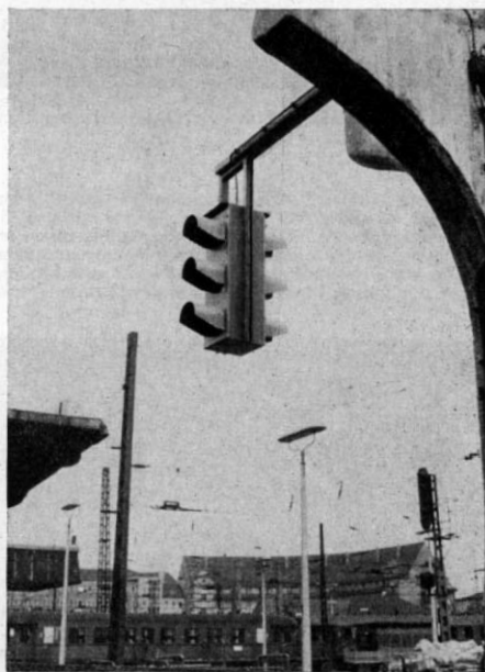
Abb. 1. Auf diesem Bild noch brandneu, inzwischen aber schon leicht „bemoost“: ein Original-BUBA-Bremsprobe-Signal auf dem Nürnberger Hauptbahnhof. Beachten Sie bitte, daß es eigentlich zwei Signale sind, d. h. die Signalbilder sind von vorn und hinten zu erkennen, weil man ja nicht alle Züge so halten lassen kann, daß die Loks stets alle an ein und derselben Stelle (z. B. vor dem Bremsprobe-Signal) stehen.
