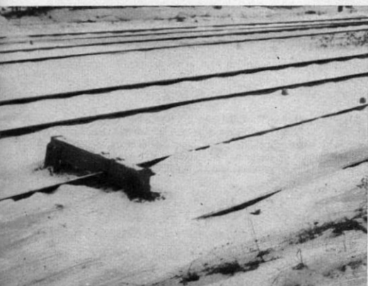
Abb. 4. Ebenfalls eine Gleissperre, die zwar etwas primitiv anmutet, aber sicher ebenso ihren Zweck erfüllt: Ein Holzbalken, der über die Schiene geklappt und mit einem soliden Vorhängeschloß „verriegelt“ wird. Entdeckt von Herrn H. Ducke, Berlin, im Bf. Bad Eilsen der Bad-Eilsener-Kleinbahn.
