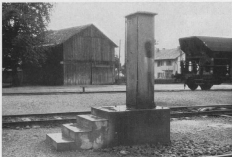
Abb. 2. Die Zapfsäule für Dieselkraftstoff im Bf. Staufen/Br. Die eigentliche Zapfeinrichtung mit Schläuchen und Zapfhähnen befindet sich im Inneren und ist bei Nichtgebrauch durch die schmale Tür auf der Treppenseite verdeckt; ihre Nachbildung ist also sehr einfach: einfach weglassen (die Zapfeinrichtung natürlich, nicht die Tür!) und einen H0-„Bahnerer“ postieren, der gerade im Begriff ist, die Tür zu öffnen!
