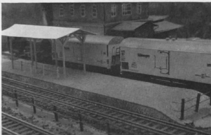
▼ Abb. 5. Die Bahnsteigüberdachung im Rohbau.
