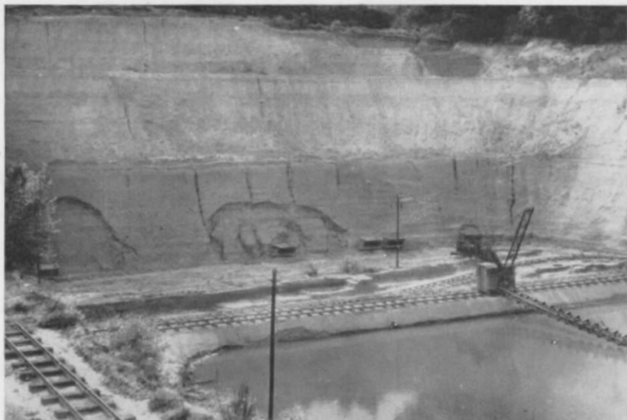
Abb. 9. Teilansicht der Formsandgrube mit den 3 treppenförmigen Sohlen. Der Greiferbagger ist auf der mittleren Sohle stationiert, wo auch ein Feldbahngleis verläuft. Der Greiferbagger fährt übrigens bis 40 cm an den Abgrund heran, da der Formsand an sich sehr fest sitzt. Die abgerutschte Wand in der Bildmitte ist lediglich eine Folge der winterlichen Frosteinwirkung.
