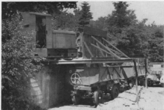
Abb. 5 zeigt deutlich die Kupplung und die Sicherung der Kipploren. Die Lore rechts weist sogar einen kleinen Bremsenstand auf (eine weitere Anregung für Egger!).
