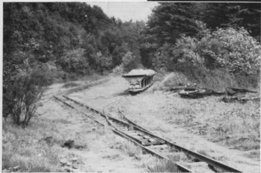
Abb. 8. „Die Fahrt ist keineswegs zu Ende, im Gegenteil das Bild spricht Bände“ ... über die richtige Verlegung von Egger-Gleisen und -Weichen. Da, wo die Gleise schon lange liegen, sind die Schwellen halb oder ganz ins Erdreich eingedrückt, während sie in der Grube selbst abenaufliegen (s. Abb. 9). Feldbahngleise werden in keinem Fall eingeschottert! Dagegen sollte man nicht vergessen, tüchtig Gras und Unkraut zwischen die Schwellen zu „säen“. Die verschiedenen Grassmatten im Verein mit Streugras werden uns hier sicher gute Dienste tun!
