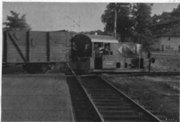
Abb. 1 und 2. Von Herrn W. Hein, Gars am Inn, entdeckt: die fast rechtwinklige Gleiskreuzung eines Industrieanschlußgleises und eines Nebenbahn - Streckengleises vor Bf. Traunstein. Man beachte die unter der Kreuzung diagonal verlegten Schwellen!
