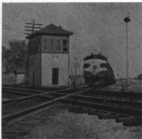
Abb. 3. Stumpfwinklige Kreuzung zweier Vollbahnen bei Huntingdon (irgendwo in USA), die signaltechnisch zwar gesichert, aber dennoch die verantwortliche Aufmerksamkeit des Stellwerkbeamten und des Lokführers erfordert! Solche stumpfwinklige Kreuzungen zweier Hauptbahnen dürften in Deutschland kaum mehr bestehen.
