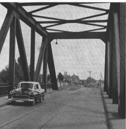
Abb. 4. Teerdecke und Rillenschienen der Brücke vereinfachen die Nachbildung im Kleinen.
