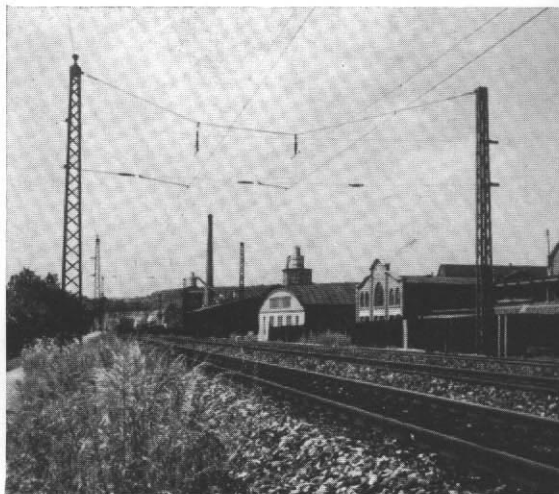
Abb. 19 und 20. Querverspannung über 3 Gleise (eines davon ohne Oberleitung) im Großen und als Sommerfeldt-Modell.
