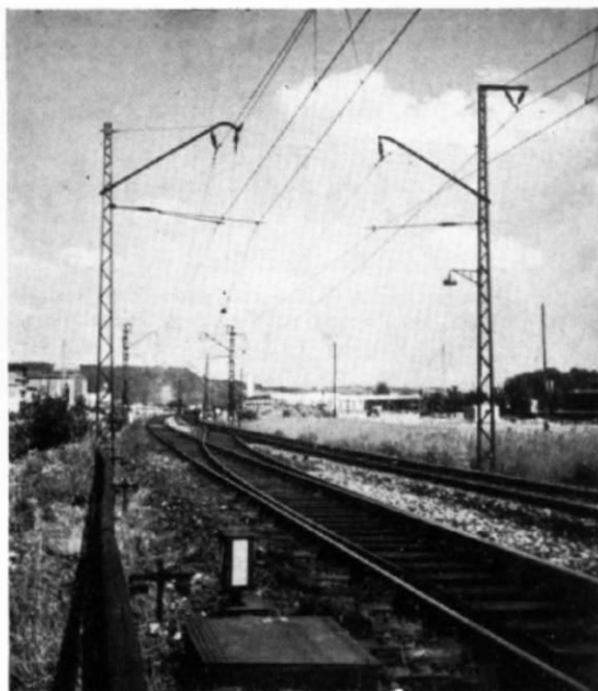
Abb. 9. Mast mit zweitem Seitenhalter bei einer Situation nach Abb. 7 C beim Vorbild.
