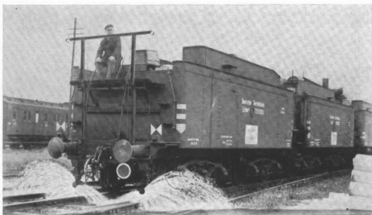
Abb. 4. Unkrautverteilungszug der DB, der dem Verfasser als Vorbild für seinen kleinen „Dreckverteilungszug“ vor-schwebte (Foto: Bellingrodt).
