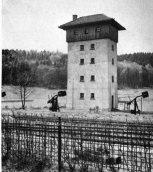
Abb. 1. Vier Weichenspannwerke in der Art der VOLLMER'schen Neuheit in einem süddeutschen Bahnhof. (Fotos: S. Buße, München.)
