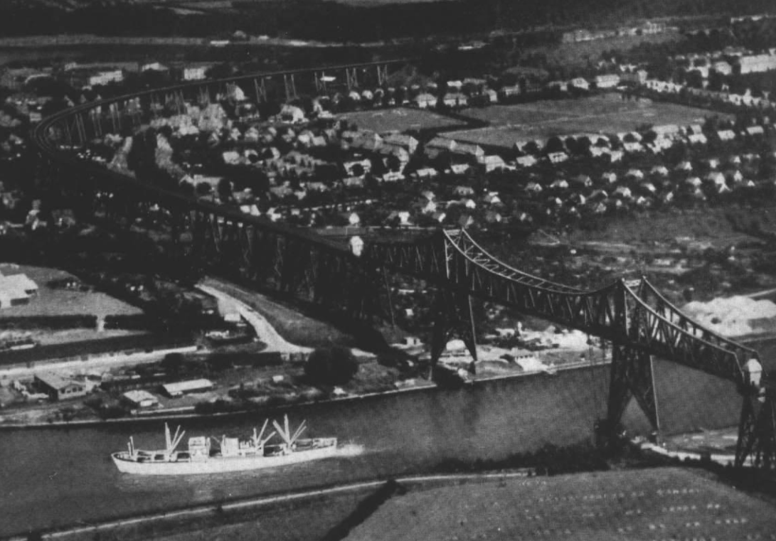
Abb. 6. Die Rendsburger Schleife (Luftaufnahme Schöning, Lübeck). Die Spannweite des Teils über dem Kanal beträgt 140 m, die Höhe 42 m, die gesamte Länge der Hochbrücke 2500 m. Die vom Verfasser ausgewählten besonders charakteristischen Teilstücke sind gut erkennbar.
