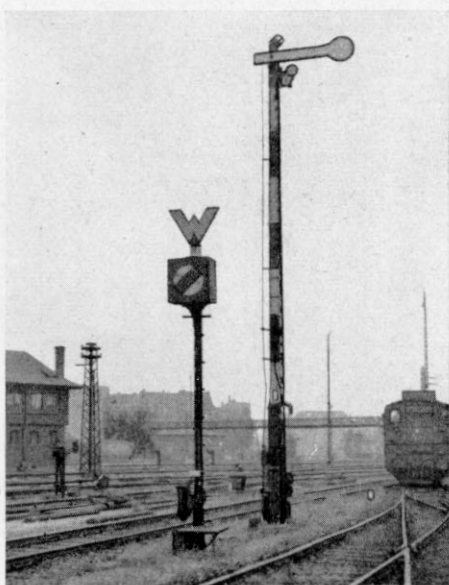
Abb. 2: Einflügeliges Hauptsignal und Gleissperrsignal mit Wartezeichen.
