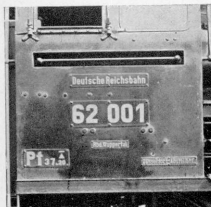
Rechte Führerhausseite der 62 001. Diese ist eine Personenzug-Tenderlok (Pt) mit 3 gekuppelten Treibachsen und insgesamt 7 Achsen (2C2) und 20 t Achsdruck.
