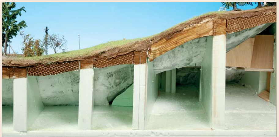
Das Anlagensegment von hinten. Der Unterbau ist weitgehend aus Styrodur gefertigt; so ist er sehr stabil und weist trotzdem kein allzu hohes Gewicht auf – und auf jeden Fall ein deutlich geringeres als ein vergleichbarer Holzkasten.
