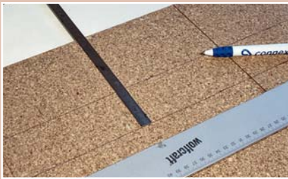
Vor der Gleisverlegung wird zuerst der Verlauf auf der Grundplatte markiert.
