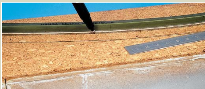
Das spätere Verlegen der Gleise mit Einzelschwellen erfordert einen exakten Aufriss der Gleislage. Dabei hat sich die Verwendung eines Kurvenlineals für den Aufriss der Gleisbögen als sehr vorteilhaft erwiesen. Baufotos: Wolfgang Besenhardt
