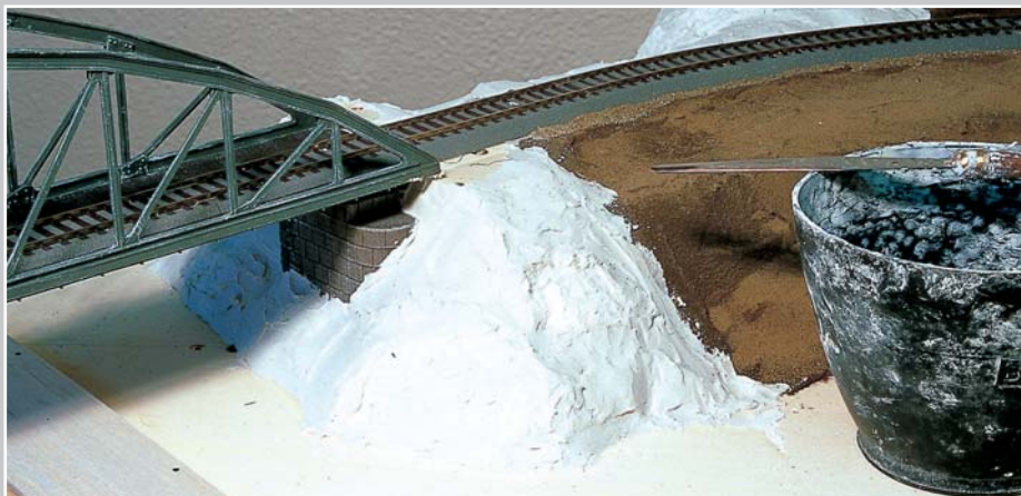
Der Dammunterbau im Bereich der Brückenwiderlager erhielt einen dünnen Gipsauftrag (Moltofill), in den gegossene Felsstücke integriert wurden.
