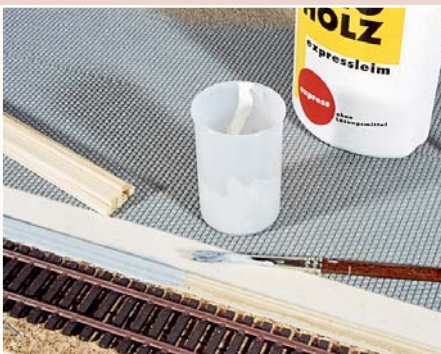
Als Abschluss der Ladestraße zum Gleis dient eine Holzleiste.
