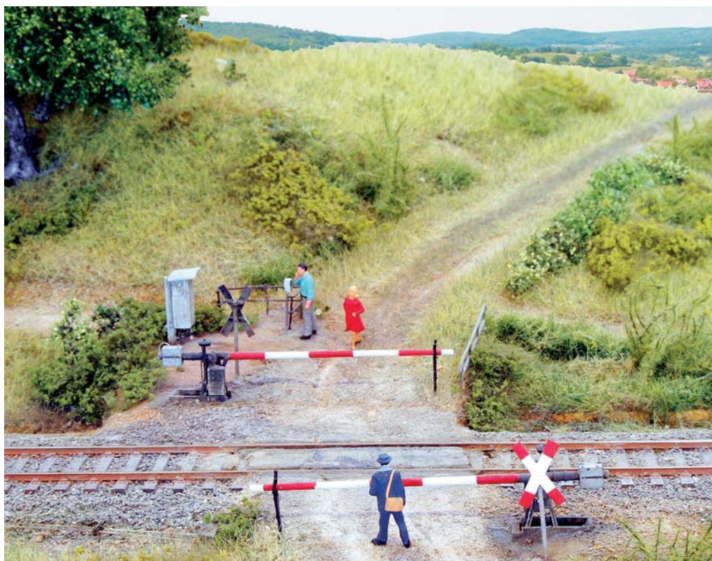
Eine besondere Form eines Bahnüberganges ist die sogenannte Anrufschränke, die erst auf telefonische Aufforderung durch den benachbarten Schrankenposten geöffnet wird. Man trifft sie für untergeordnete Straßen und Feldwege in der Regel auf vielbefahrenen Strecken an, wo der Verkehr eine bessere Sicherung erfordert.
