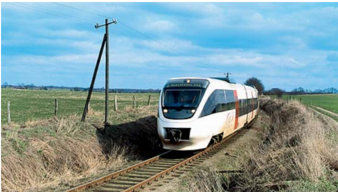
Eine Kiesbettung ist in Norddeutschland bei vielen Nebenbahnen zu finden, hier bei Feldberg/Meckl. im März 2000.
