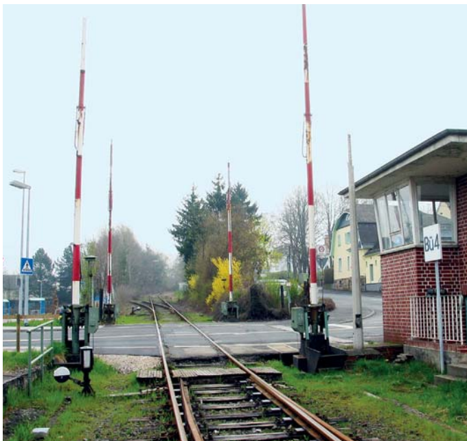
Die sicherste Form einer Straßenquerung: ein mit Vollschranksen gesicherter Bahnübergang. Zusätzlich sichern Andreaskreuze den Bü, falls die Schranken sich nicht senken. Auch findet sich hier ein Schrankenwärterhaus, von dem aus die Schranke bedient wird.
