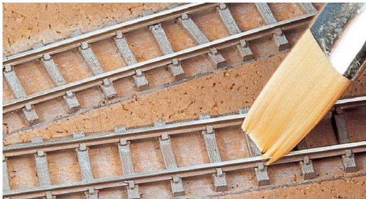
Pflicht und Kür sind die immer wieder durchzuführenden Probefahrten. Etwaige Kontaktprobleme lassen sich jetzt noch gut beseitigen.
