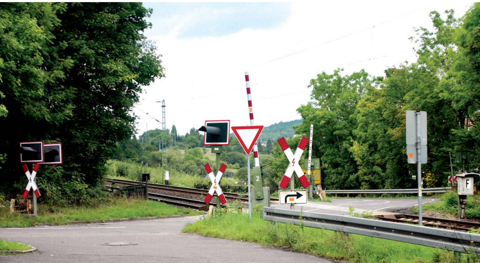
Eine typische Halbschrankenanlage an einer zweigleisigen Strecke in aktueller Bauform. Foto: Jens Weber
