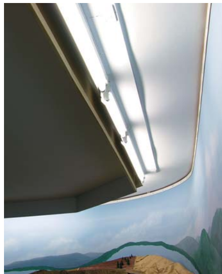
Für die Beleuchtung der Hintergrundkulisse verwendete ich einfache Fassungen für die Leuchtstoffröhren mit einem einseitigen Reflexionsschirm.
