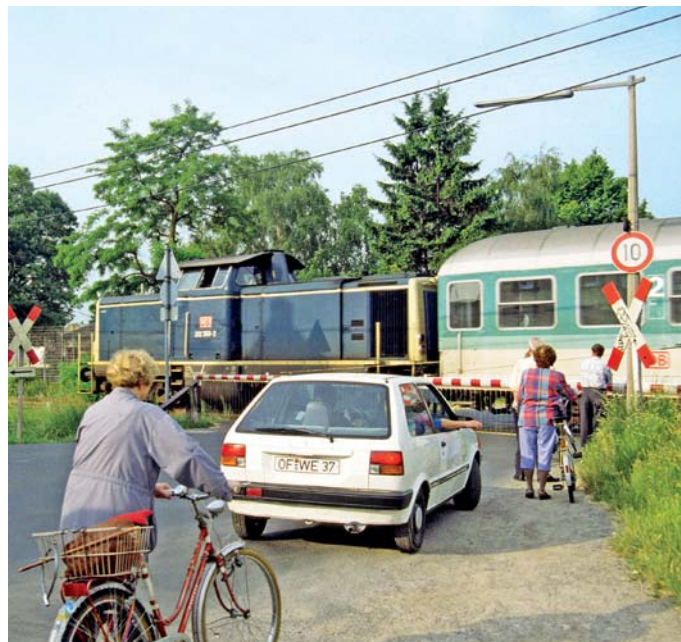
Im Bahnhof Bieber – an der Rodgaustrecke – wird der Bahnübergang direkt am Bahnhof durch einen Vollschranksenabschluss gesichert. Die Andreaskreuze werden – zeitgemäß – durch Farbschmierereien verziert.
