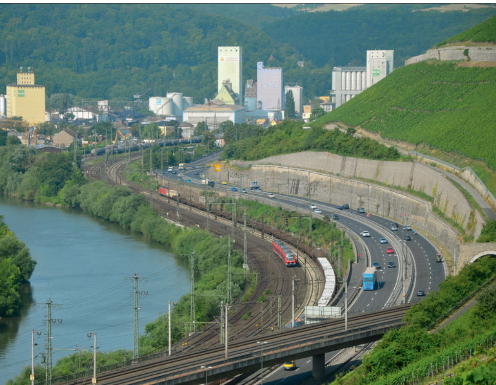
Die Schnellfahr- respektive Paradenstrecke verschwindet unter dem Weinberg, darunter schlängeln sich die Regional- und Güterzüge auf dem S-förmigen Verlauf in Richtung Hanau.
