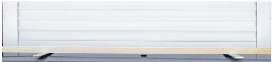
Oben: Der sich in der unteren Endlage befindliche Rollladen. Links und rechts sind kräftige Winkel als tragende Elemente angeordnet. Mittig ein zusätzlicher, kleinerer Winkel.
