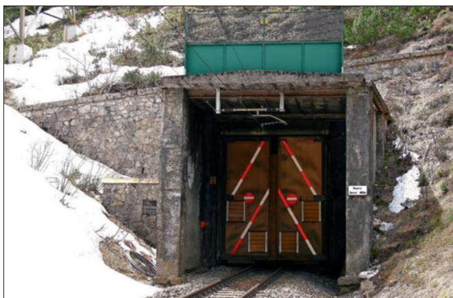
Gebirgsstrecken wie die Albulastrecke der RhB besitzen an den Portalen zum Schutz vor Schnee oder unbefugtem Betreten automatisch öffnende Türen. Zum Schutz vor Lawinen oder Geröll wurde vor das Portal eine Galerie aus Beton gesetzt.
