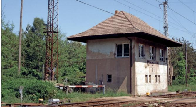
Mechanische Stellwerke wie in Chorin (oben) und Herzberg (Mitte) haben im Obergeschoss Diensträume mit guten Sichtmöglichkeiten auf die Strecke. Die Spannwerke für die Seilzugleitungen sind im Erdgeschoss untergebracht. In größeren Bahnhöfen hatte meist jede Bahnhofseite ein eigenes Stellwerk, bei kleineren genügte dagegen eines in der Mitte des Bahnhofs.
