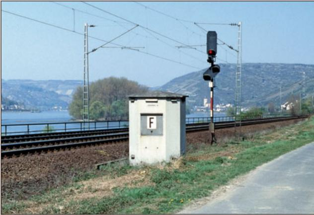
Vor dem Blocksignal steht eine Fernsprechbude aus Betonfertigteilen (oben). Sie war ein Einheitsbau der Deutschen Bundesbahn.
