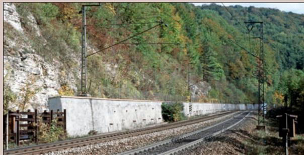
An der massiven Stützwand bei Geislingen sind im unteren Drittel die Auslässe für die Entwässerung zu erkennen.
