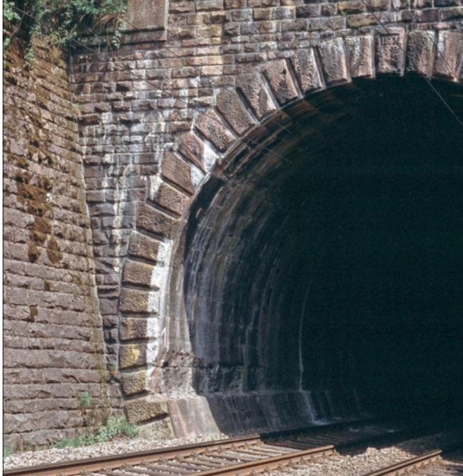
Der Hinterburg-Tunnel bei Neckarsteinach aus Natursteinen besitzt heute eine massive Tunnelsohle aus Beton. Im Inneren und am Portal sind Flecken von kalkhaltigem Gebirgswasser zu erkennen. Am Rand der Bogenlaibung ist ein älterer weißer Warnanstrich zu erkennen.
