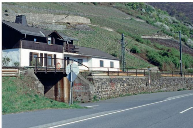
Um den Höhenunterschied zwischen Gleis und Straße zu sichern, errichtete man hier eine Stützwand. Die niedrige Unterführung ist nur für Pkws und Fahrradfahrer passierbar.
