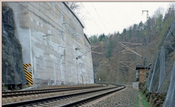
Bei Tharandt sicherte man einen Einschnitt mit einer hohen Be- tonwand (links).
