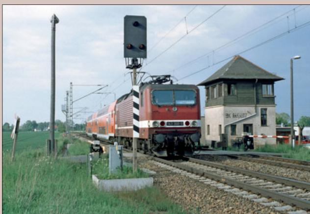
Der Block Basslitz bei Dresden steuerte zuletzt Lichtsignale. Die Schranken hatten fernsteuerbare Elektroantriebe in der Bauart der Deutschen Reichsbahn.
