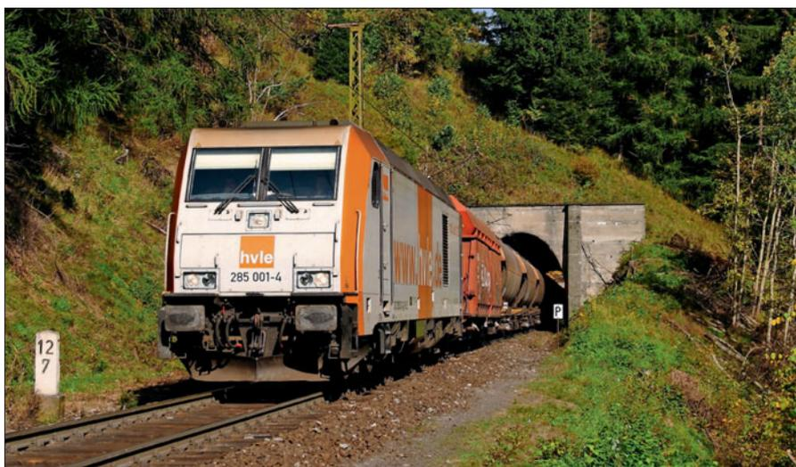
Die Rübelandbahn im Harz hat Tunnel aus Stahlbeton, die nach vorne durch Pfeiler und Stützen stabilisiert werden. Das Portal reicht seitlich weit in die Böschung des Berges. Man erkennt Warnanstriche und Wasserflecken.
