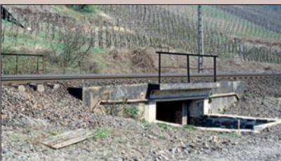
Entwässerungsgräben werden durch Röhren oder mit Durchlässen durch Hindernisse geführt. Öffnung im Fundament eines Mastes (oben), Durchlass unter einem Weg (Mitte) und Durchlass unter einer Eisenbahnstrecke (unten). Am Oberalp-Pass baute man neben die Gleise einen Graben aus Betonsteinen, der Wasser ableitet (rechts).
