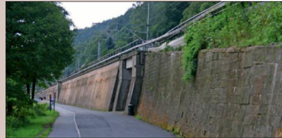
Zum Hochwasser- schutz der Bahn- strecke dient in Bad Schandau eine mas- sive Betonwand (oben rechts).
