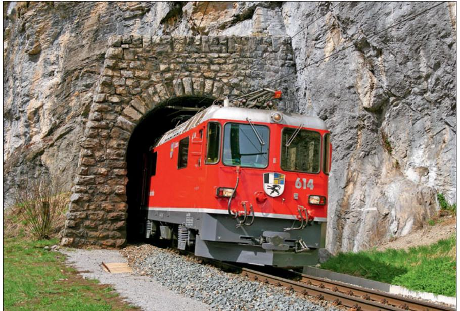
Bei Bergün an der Albula-Bahn befindet sich einer der vielen kleinen Tunnel im Netz der Rätischen Bahn. Er wurde aus Natursteinen gebaut und das Portal einige Meter vor die eigentliche Öffnung gesetzt (oben links). Direkt am Tunnel befindet sich der fast senkrechte Felshang (oben rechts). Der Tunnel besitzt nicht den typisch runden Querschnitt, sondern fast senkrechte Seitenwände. Im Inneren ist der Querschnitt sehr gering und der Fahrdrabt mit Deckenhalterungen befestigt (links).
