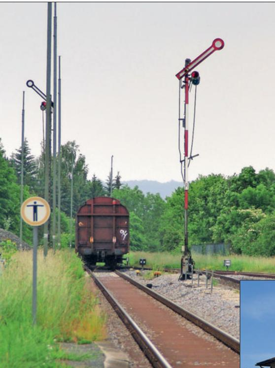
Ähnlich einem technischen Freilichtmuseum sind im Bahnhof Rothenburg zwei alte Hp1-Signale in der Ausfahrt Richtung Steinach samt Seilzugeinrichtungen aus früheren Tagen zu bestaunen.
