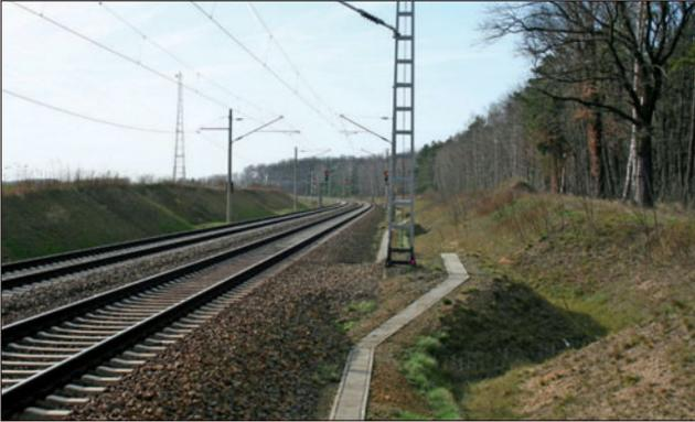
Neben den Steuer- und Fernspregleitungen in Betonkanälen wurde hier eine Mulde zum Ableiten des Wassers angelegt.
