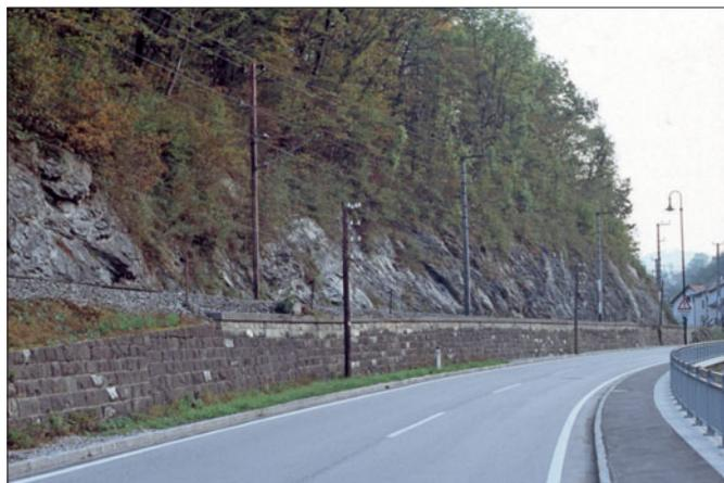
An der Mariazellbahn bei Laubenbachmühle stützt sich die Bahntrasse auf eine Natursteinwand. Den Felsen sprengte man für die Bahn weg. Oberhalb der Felsen findet man dichten Bewuchs.
