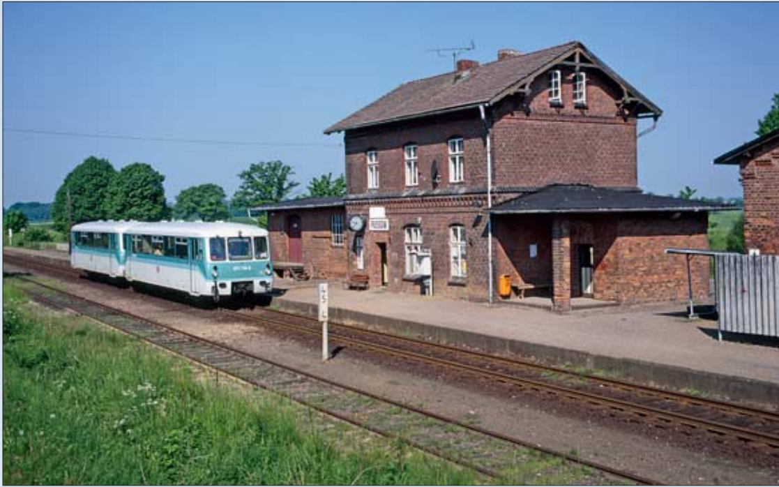
Der kleine Bahnhof Passow in Mecklenburg war zwar kein Endbahnhof, bot aber noch zu Beginn der 1990er-Jahre mit seinem bescheiden Empfangsgebäude samt angebautem Güterschuppen, dem vergrasten Ausweichgleis in Kiesbettung und dem einfachen Bahnsteig ein ideales Vorbild für die Gestaltung typisch ländlicher Bahnhöfe im Modell. Foto: Udo Kandler
