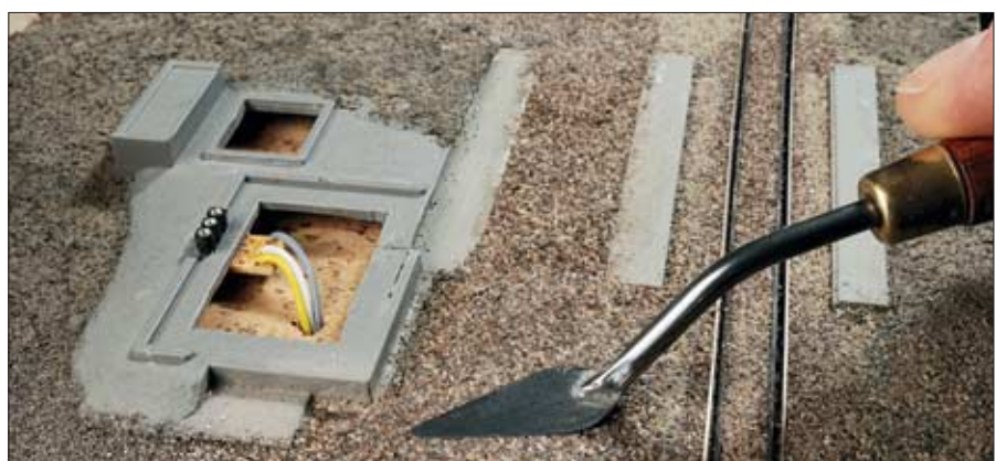
In das Fundament ist eine dreipolige Präzisionsbuchsenleiste für zwei schaltbare Stromkreise integriert, um das Gebäude problemlos bei Bedarf abnehmen zu können. Mit einem Spachtel wurde der mit Latexkleber getränkter Schotter bzw. Splitt glatt gezogen.
