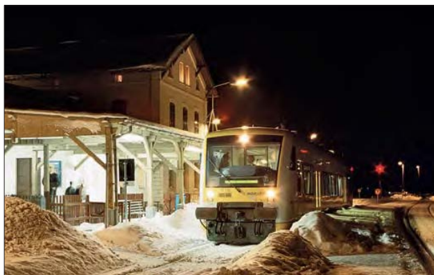
In Mulda (Sachsen) wurde der Bahnhof saniert, aber das alte Bahnsteigdach hat man erhalten. Unter dem Dach ist eine helle Beleuchtung aus Neonröhren vorhanden. Das restliche Bahnhofsumfeld ist mit hohen Laternen deutlich dunkler ausgeleuchtet. Foto: Uwe Henkel
