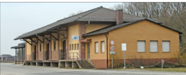
Ansicht von der Straßenseite. Ein Objekt zum Nachbau im Modell!
