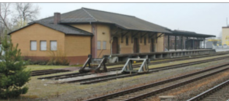
Die Gleisseite des Güterschuppens im Bf Hersbruck rechts Pegnitz
