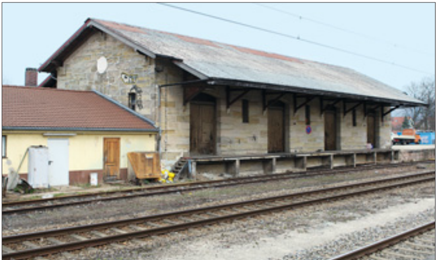
Der im gleichen Stil erbaute Güterschuppen weist noch einen Gleisanschluss auf.
