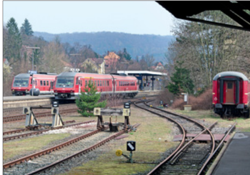
Bild oben: Man beachte die beiden völlig unterschiedlichen Ausführungen von Prellböcken in unmittelbarer Nachbarschaft im Bf Hersbruck re P. Neben dem Gleis am rechten Bildrand befindet sich der nicht mehr genutzte Güterschuppen. Beim Triebwagen in Bildmitte handelt es sich um den hinteren Teil eines geflügelten Zuges, der im Bf getrennt wird.
