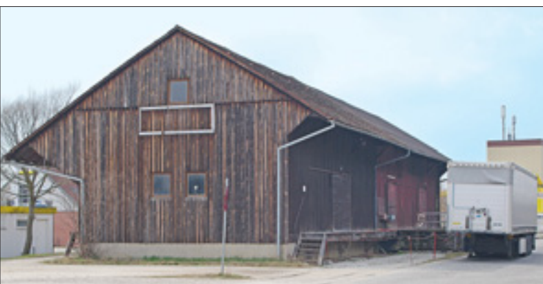
An der Zufahrtsstraße zum Bahnhof liegt dieser Holzschuppen. Im Straßenplanum ist noch der Gleisanschluss vorhanden.
