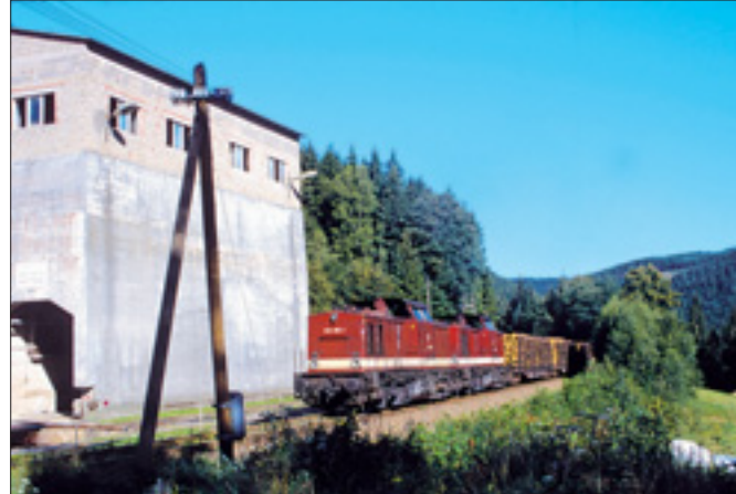
Verladestelle des Granitwerkes Heberndorf. Die Zuführung des Schotters geschah mittels Seilbahn vom Tagebau Heberndorf. Foto: AMB-Design
