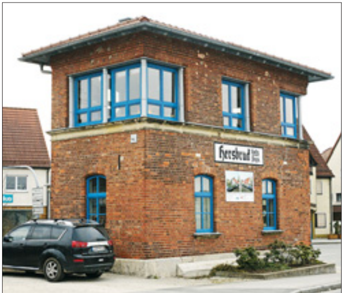
Eines der erhaltenen Stellwerke des Bahnhofs Hersbruck links Pegnitz. Das Schild weist noch die alte Frakturschrift auf.
