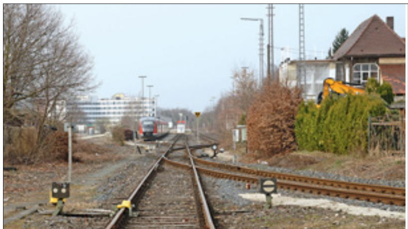
Unten: Der nach rechts weisende Abzweig ist das Streckengleis der Gräfenbergbahn, im Hintergrund der Bf Nürnberg-Nordost. Links das normale Abstellgleis mit DB-Triebwagen. Etwa auf Höhe der Gleissperre beginnt der Privatgleisanschluss.
