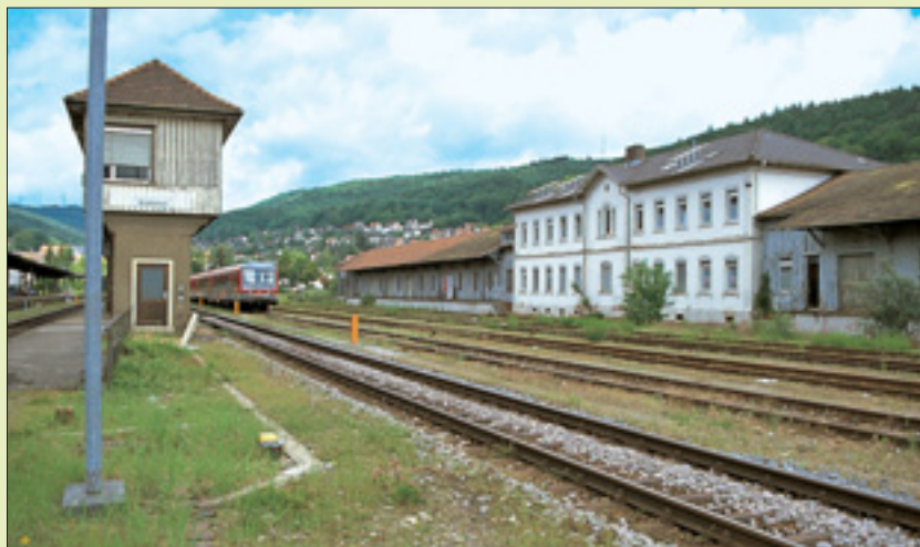
Die ehemaligen Zoll- und Güterabfertigungsgebäude im Umfeld des Stellwerks existieren heute nicht mehr.
