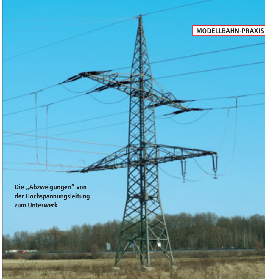
Die ankommenden Hochspannungsleitungen führen vom Turmmast hinunter zum Unterwerk.
