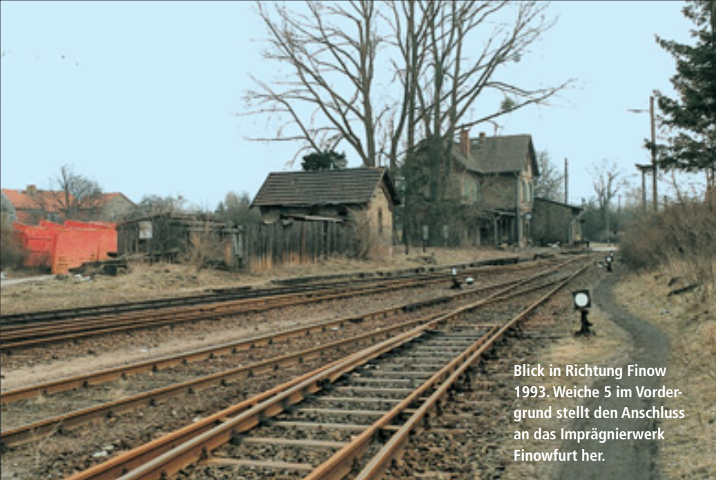
Der Triebwagenschuppen war die letzten Betriebsjahre der Bahn nicht genutzt. Prellböcke waren an den Zufahrtsgleisen montiert. Die Bahnanlagen weisen in den 90er-Jahren bereits einen schlechten Unterhaltungszustand auf. Die Weichen im Vordergrund bestehen aus Stahlschwellen.
