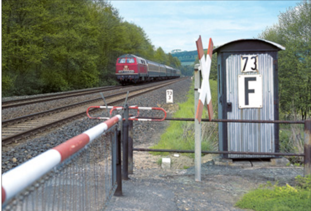
Drehkreuze sicherten an Anrufschraken den Bahnübergang gegenüber Fußgängern, wie hier an der Strecke Weiden–Schwandorf bei Wernberg–Köblitz. Fotos (2): Udo Kandler
