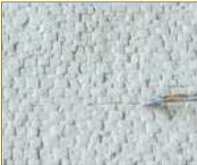
Die Stoßstellen der Mauerteile werden mit flüssigem Gips behandelt.
