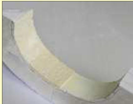
Die Gewölbeabdeckung besteht aus aneinandergefügten, 4 cm breiten Mauerteilen.
