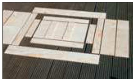
Die einzelnen Bauteile für den Rahmenbau wurden nach Zeichnung im Baumarkt zugeschnitten.
