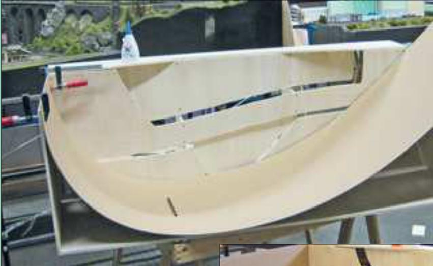
Der Kasten mit der Rückwand und den beiden Seitenwänden steht, auch die Gleistrasse ist schon mit den Spanten verklebt und verschraubt.
