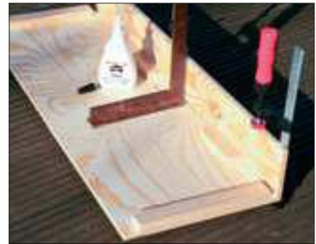
Rahmenwangen und Deckplatten werden anschließend verleimt und verschraubt. Zur Fixierung während des Leimens dienen Schraubzwingen.
