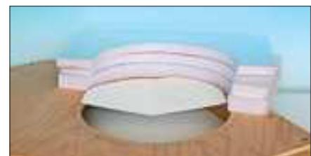
Nach der Schnittmustervorlage wird der Bogenverlauf am Styrodur ausgeschnitten.
