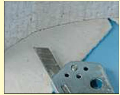
Mit einem scharfen Messer werden behutsam überstehende Mauerteile abgetrennt.
