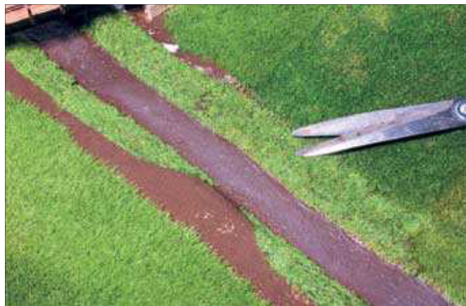
Das Ufer des Baches wird mit Wiesengrasmatten von Heki belegt. Diese schneidet man in passende Streifen.
