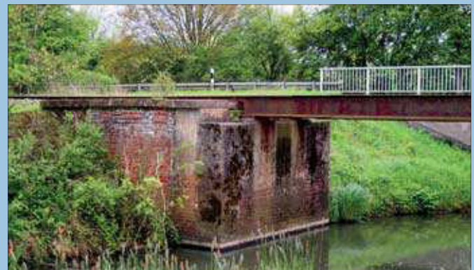
Überquert eine Schmalspurbahn einen Graben, reicht meist eine ganz einfache Stahlträgerbrücke aus. Der Pfeiler steht halb im Gewässer.
