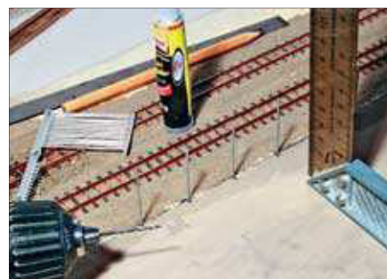
Die Zaunpfosten (Weinert) werden senkrecht in Bodenbohrungen eingeklebt.
